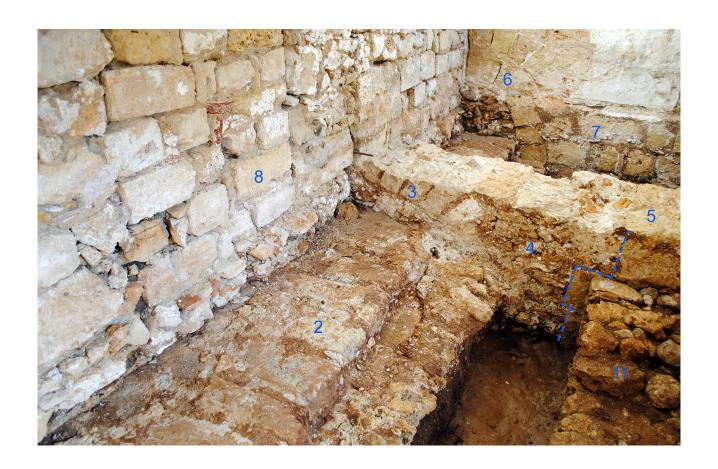
7.6 Palermo, Cuba Soprana, area 8. I due muri normanni (4 e 7) sono stati dotati di archi di scarico (3 e 6) per proteggere le condutture idrauliche (2). Su di essi si fonda un muro (8) che appartiene alla trasformazione del XVI secolo. Al numero 5 corrisponde la fondazione di uno dei pilastri del portico normanno. (Laboratorio de Arqueología y Arquitectura de la Ciudad, Escuela de Estudios Árabes, Consejo Superior de Investigaciones Científicas)
