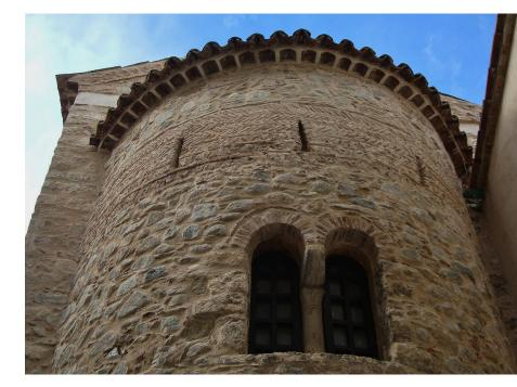
posizione di due semiarchi nel pattern detto 'a coda di rondine', che scandisce l'abside maggiore, le facce dei due tamburi e il prospetto occidentale. Le fiancate, a differenza di Bivongi, sono anch'esse movimentate da nicchie, alternatamente cieche e con monofora.
