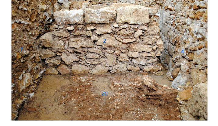
rocce e permettevano ai visitatori di contemplarle da vicino. Il muro perimetrale della vasca, con uno spessore di 1,45 m, è realizzato in muratura con malta terrosa di colore rosso scuro e rinforzato all'interno con un rivestimento in conci atti a contrastare la pressione dell'acqua [Figg. 7.2, 7.15, 7.16].
